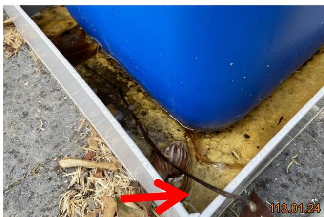
應科大樓 4 樓西北側露臺一處防洩漏盛盤內有積水，請定期清除積水，並鋪設細網避免病媒蚊孳生。
